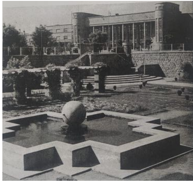
Şekil 1. Ankara Tarihi Gar Binası (Sözen & Tapan, 1973).
