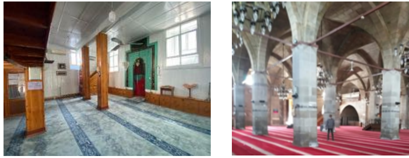
Şekil 1. Çavdar Baba Camii Eşaralıklı Aşşap dikmeleri (solda), Ulu Camii Eşaralıklı Taş Ayakları (sağda) (Kaynak: Yazara ait fotoğraf arşivi, 2021).
