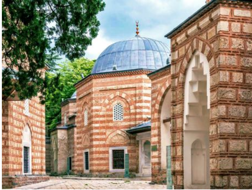
Şekil 5. Deprem güvenliği için Geleneksel yapıda Taş tuğla örgüsü.
