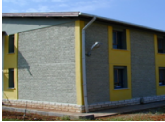
Şekil 9b. Sanayi tesiste üretilen 60 bin toprak blok ile iki katlı bina inşaatı GAP-URFA
