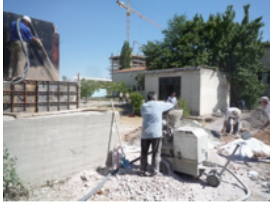
Şekil 10a. Beton Püskürtme makinası (shotcrete) ile toprak püskürtme
