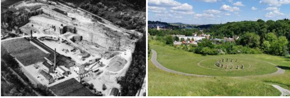
Şekil 14: Hungerberg Taş Ocağının Eski ve Yeni hali
