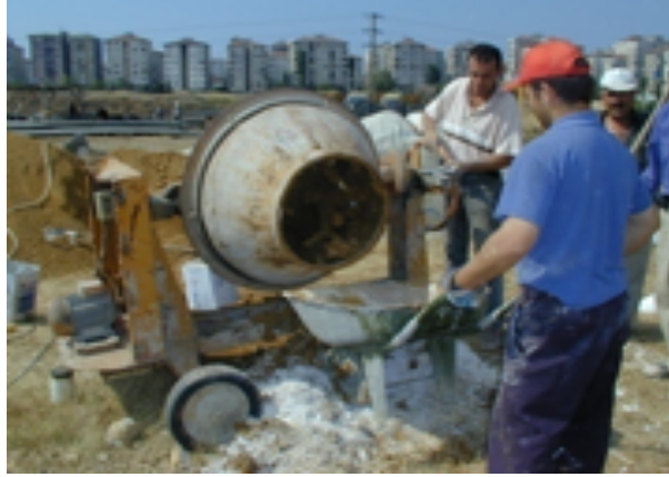
Şekil 8a. Harç makinası (betoniyer) ile toprak karıştırılması
