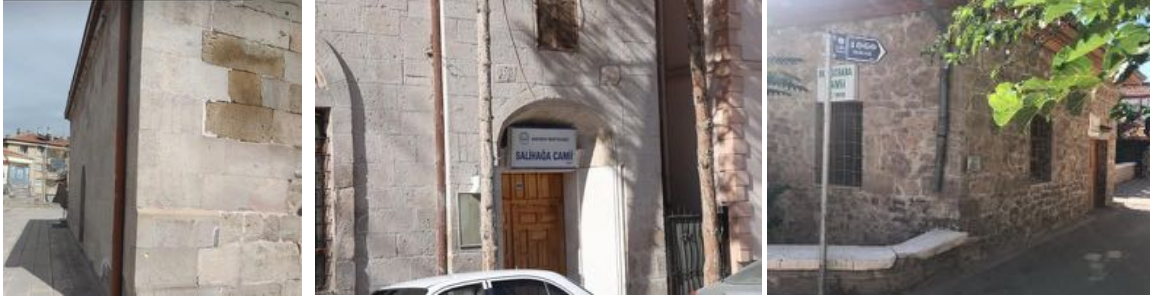
Şekil 4. Ulu Camii (solda) ve Salih Ağa Camii (ortada) kesme taş cepheleri ve Horoz Baba Camii moloz taş cepheleri (sağda) (Kaynak: Yazara ait fotoğraf arşivi, 2021)
