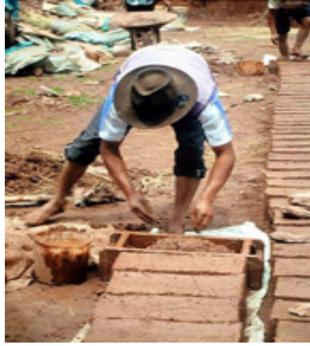
Şekil 7. Toprak+ saman karıştırarak elde edilen harç ile kerpiç kesmek (şekil vermek)
