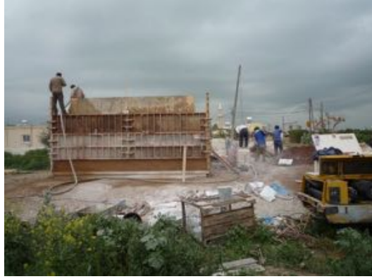
Şekil 10b. Shotcrete makinası ile Betonarme kalıbında toprak duvar inşaatı
