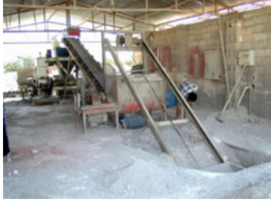
Şekil 9a. “Beton blok” üreten tesiste “toprak karıştırma ve presleme”
